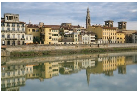
Figura 12. Esempio di rialzo delle spallette degli argini dell'Arno a Firenze, realizzate per aumentare la capacità di deflusso nel tratto cittadino
