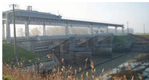
Figura 10. Manufatti regolatori dello scolmatore di Reno
