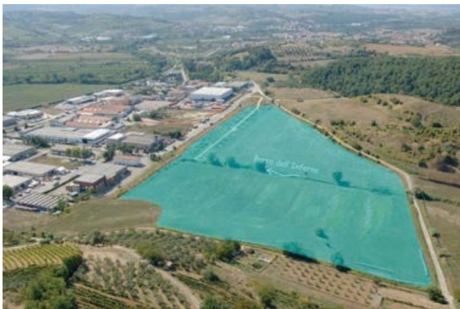
Figura 5. Cassa di espansione lineare del Borro Inferno a Certaldo (FI) realizzata per regolare la portata in ingresso del tratto intubato del corso d'acqua che attraversa l'area produttiva posta a valle
