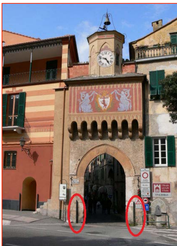
Figura 3. La storica porta testa di Finalborgo, Finale Ligure, (SV). Sono visibili le guide utilizzate per fissare le paratie di legno a protezione del centro del borgo dall'inondazioni provocate dal torrente Aquila
