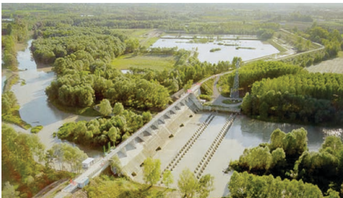
Figura 6. Cassa d'espansione sul fiume Panaro
