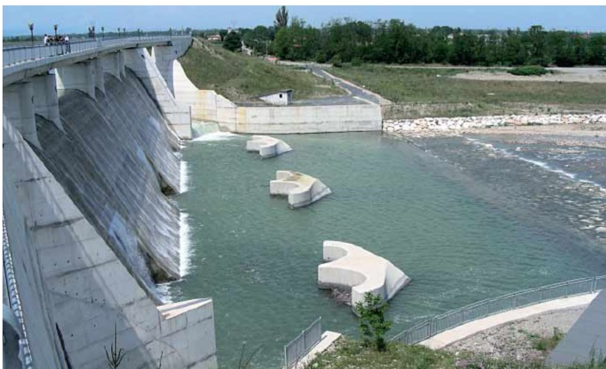
Figura 7. Manufatto regolatore della cassa di espansione sul torrente Parma
