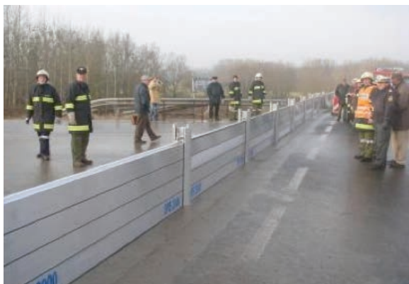
Figura 16. Barriere temporanee messe in opera in fase di pre-evento
